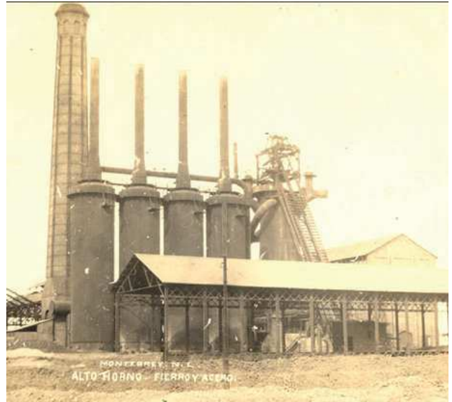
Figura 2. Alto Horno 1 de Fundidora Monterrey, a principios del siglo XX
