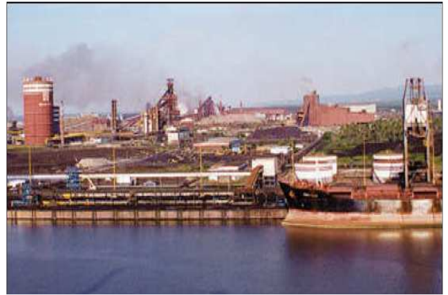
Figura 6. Instalaciones de Sicartsa.
